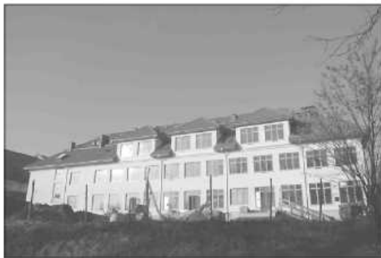
Nowy budynek szkolny jest już otynkowany
