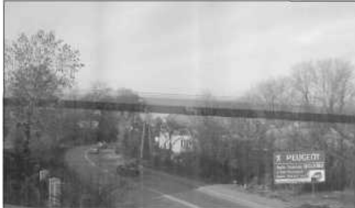
Droga ekspresowa autostradowa z estakadą nad Zielonkami – brak zgody.
