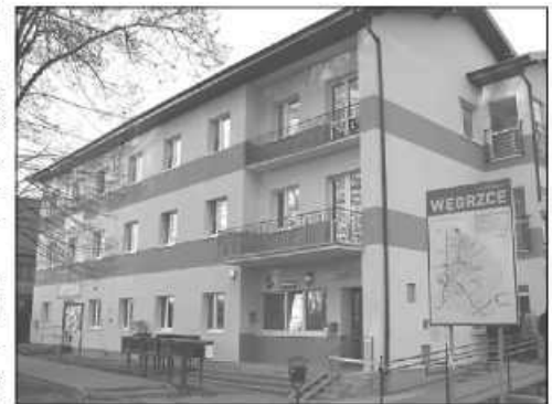
Budynek Centrum Medycznego w trakcie modernizacji
