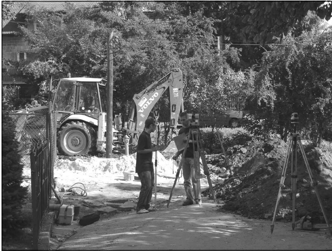
Budowa kanalizacji „Ochrona zlewni rzeki Prądnik – II etap” w Zielonkach
