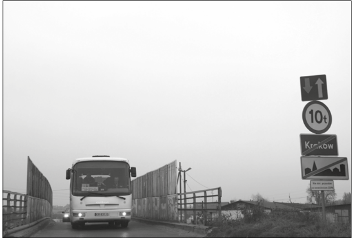
Obok istniejącego wiaduktu w Batowicach ma powstać nowy, szerszy.
